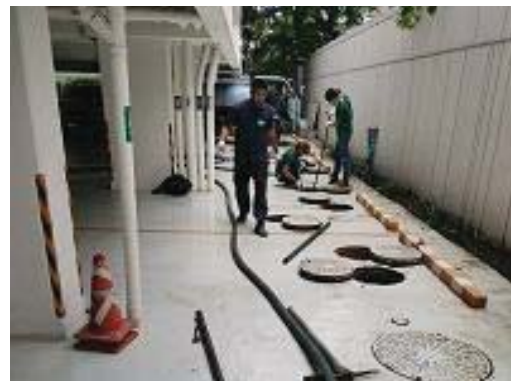
สูบล้างปลักในในระบบบำบัดน้ำเสีย
