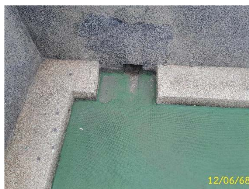
ท่อระบายน้ำฝนชั้นดาดฟ้า
