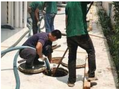
สูบล้างปลักในในระบบบำบัดน้ำเสีย
